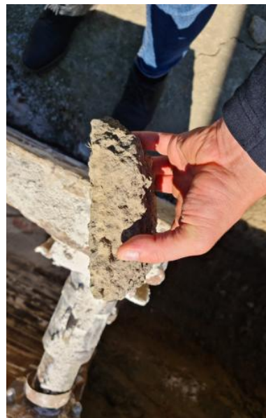
Foto: Naše cestné komunikácie sú v katastrofálnom stave - žiadne lôžko a asfalty o hrúbke niekoľko centimetrov, Ocú Bystričany
